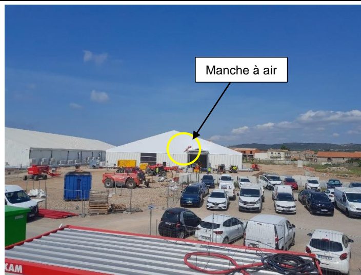
Manche à air en place sur le chantier
