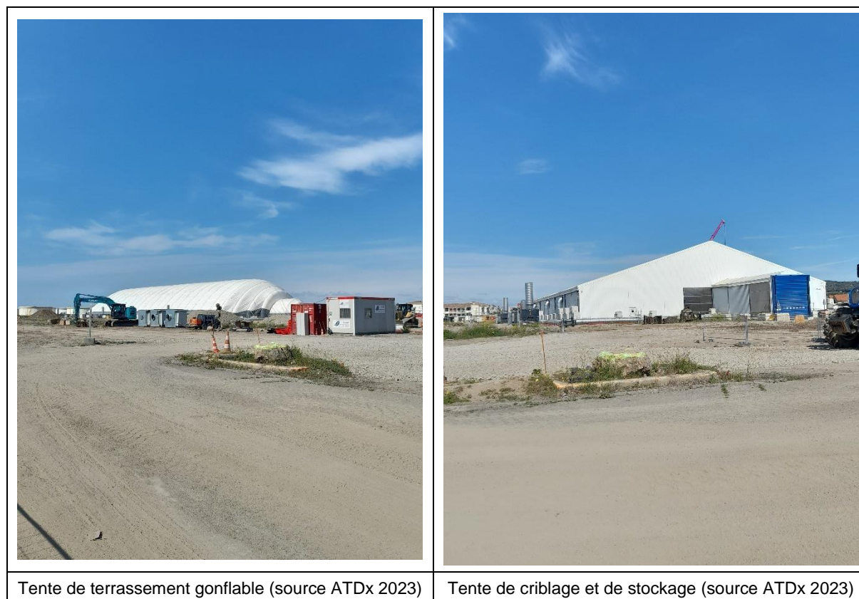
Figure 2 : Illustration des tentes mises en place sur le chantier
