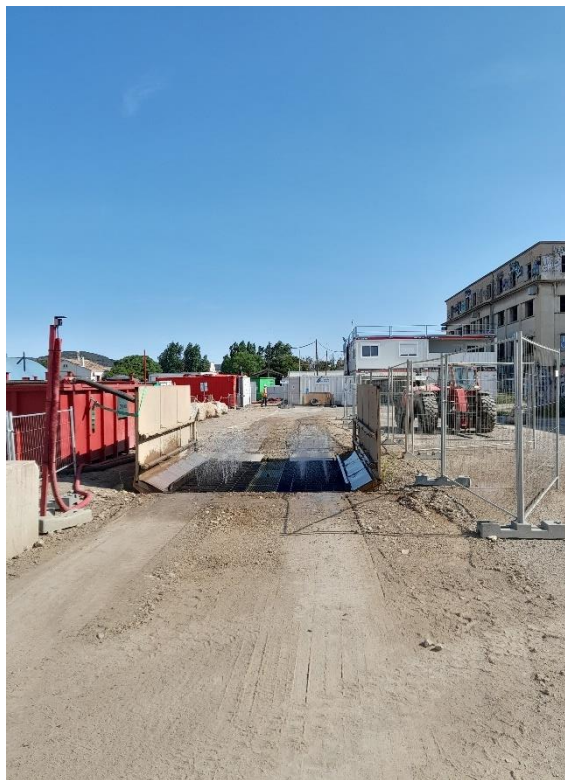
Aire de lavage des roues des camions d'évacuation (source ATDx 2023)
